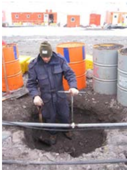
Figura III.3 Excavación realizada debajo de una de las tuberías que conducen gasoil para retirar el suelo contaminado (CRO2) que se iba a utilizar en el ensayo.
